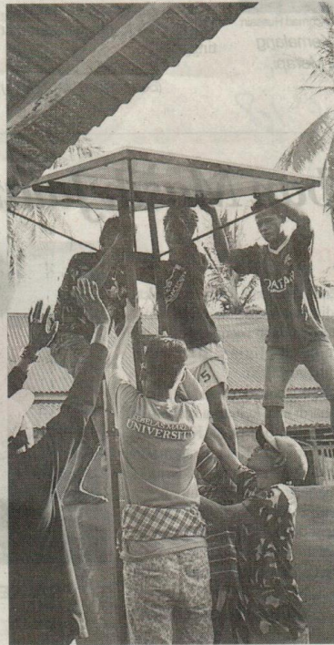
PASANG PANEL : Mahasiswa KKN UNS bersama warga memasang panel surya untuk penerangan di Desa Oeseli, Kecamatan Rote Barat Daya, Kabupaten Rote Ndao, NTT. (37)
